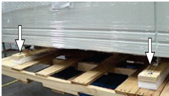
12. 找到固定托盘的 4 个 15mm (9/16") 螺栓和螺母
