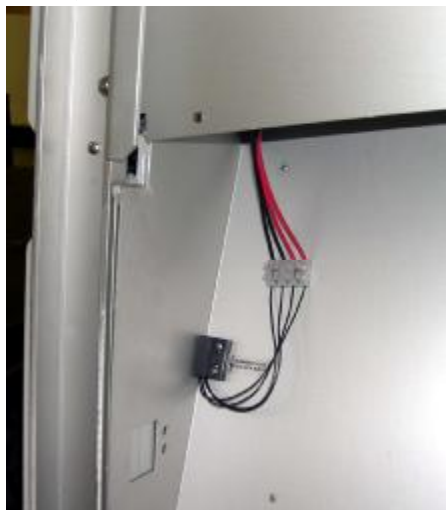
图4a：箱门连锁开关
