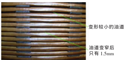
图 1 变压器绕组油道变窄情况
